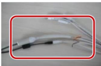
2 Обмотайте соединенные кабели изоляционной лентой.
